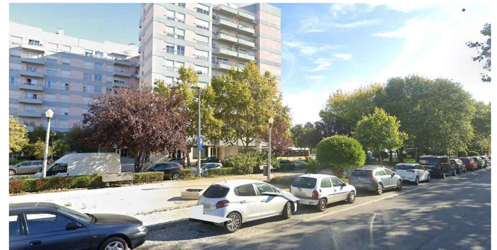
FOTOGRAFIA 2 - VISTA APROXIMADA DO LOCAL
