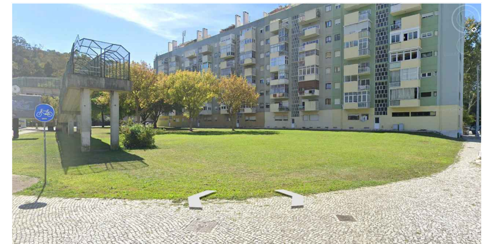
FOTOGRAFIA 2 - VISTA APROXIMADA DO LOCAL
